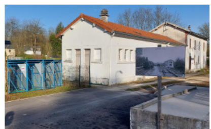
Une gare avec des équipements en mauvais état
