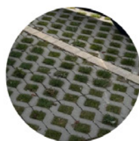
Dalles alvéolaires en béton
